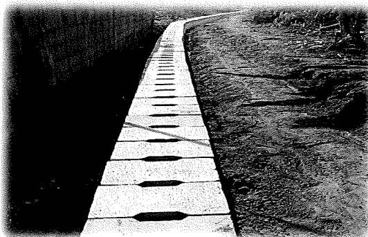
● รางระบายน้ำ คสล. หมู่ ๖
